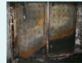
1階階段室の防火戸
