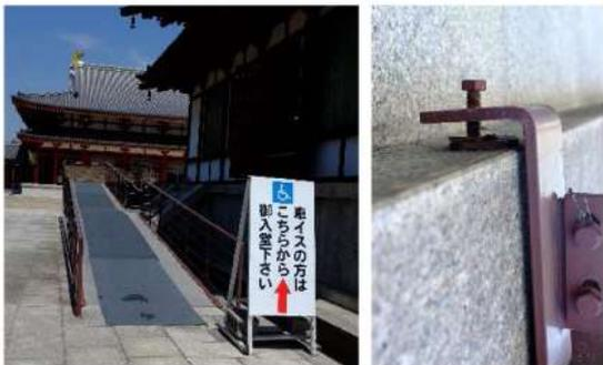
図2 基壇への仮設スロープの設置
