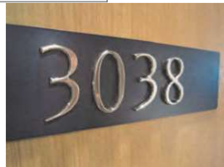
室番号の浮き彫り表示の例
