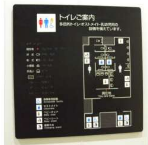
○便所の触知図案内板の設置例
